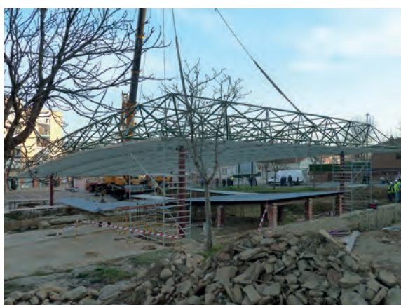
Figura 21.11. Instal·lació de la primera coberta protectora definitiva.
