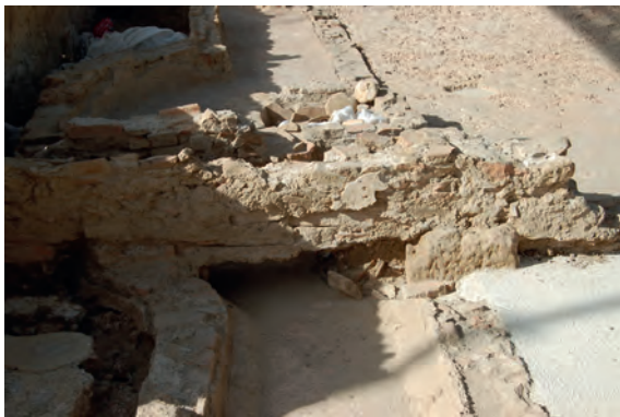
Figura 4.5: A3. Detall del basament d'una de les columnes de pedra sorrenca del porxo d'època severa, coberta pel mur baiximperial.
