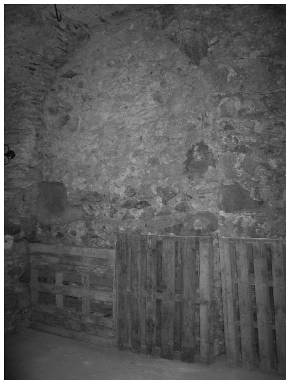
Figura 3.8. Obertures tapiades en la planta soterrània de l'edifici del convent, que podrien correspondre al palau comtal (foto AM Puig).
