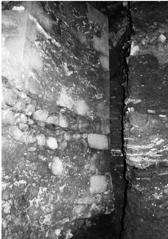
Figura 1.6. Detall del límit interior de la torre i indicis del tapiat de maons que tancava l'accés des de l'interior (foto A.M. Puig).
