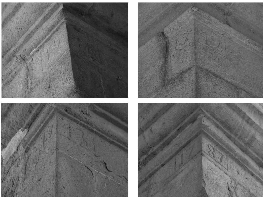
Figura 3.3. Dates de construcció de les galeries del claustre, gravades en la part superior dels pilars dels angles (foto AM Puig).
