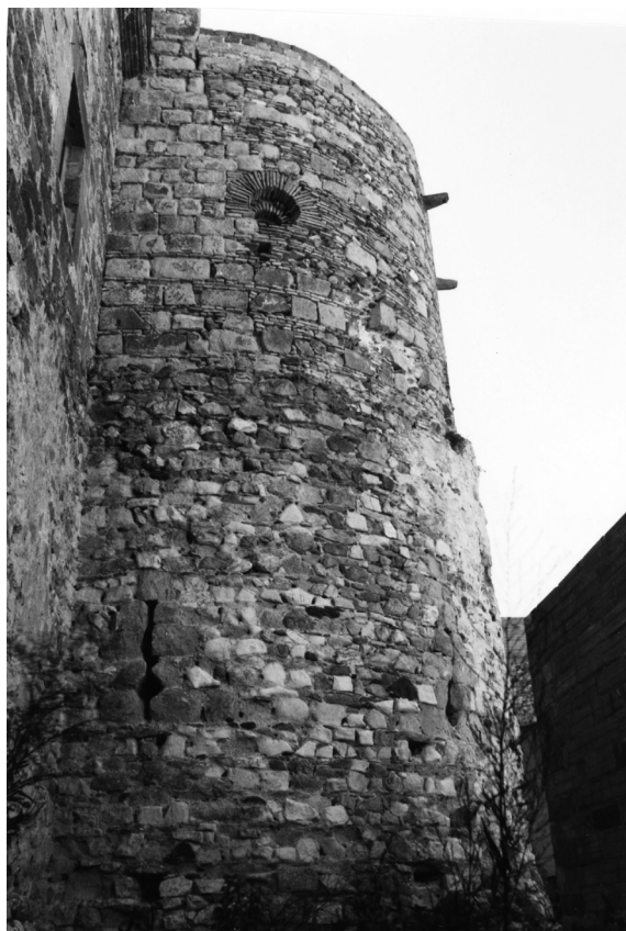
Figura 1.4. Absis de l'església que es fonamenta damunt la torre de la muralla, vista des de l'exterior (foto A.M. Puig).
