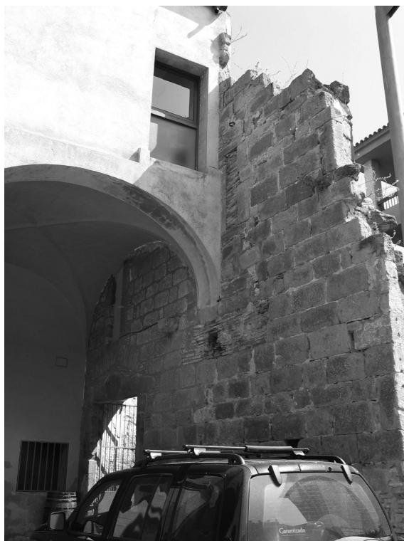
Figura 3.4. Detall d'obertures tapiades i amortitzades per la galeria del claustre del convent, que podrien correspondre al palau d'Enric II (foto AM Puig).
