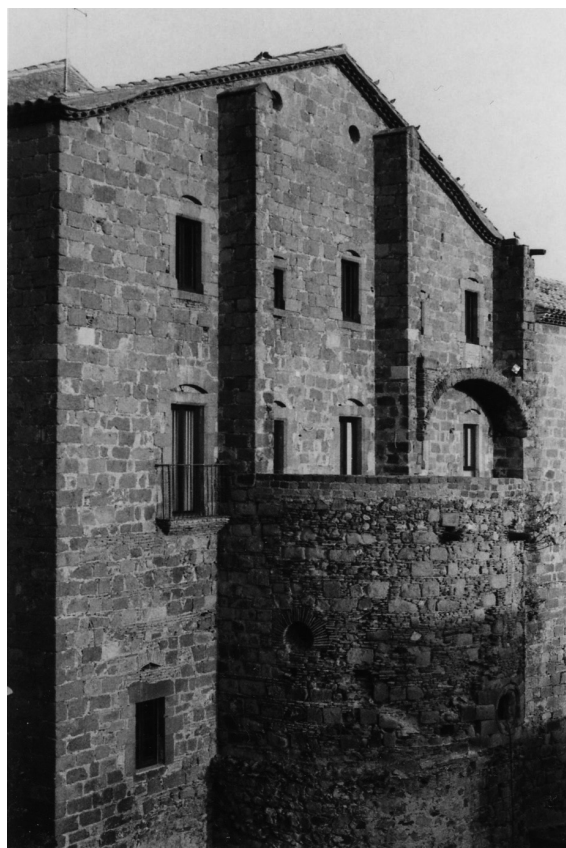
Figura 1.4. Absis de l'església que es fonamenta damunt la torre de la muralla, vista des de l'exterior (foto A.M. Puig).
