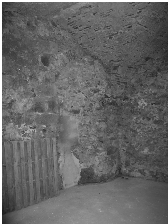
Figura 3.8. Obertures tapiades en la planta soterrània de l'edifici del convent, que podrien correspondre al palau comtal (foto AM Puig).
