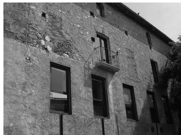
Figura 3.7. Façana sud, la més deteriorada i alterada, amb les obertures emmarcades amb maons (foto AM Puig).
